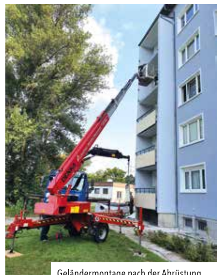
Geländermontage nach der Abrüstung
